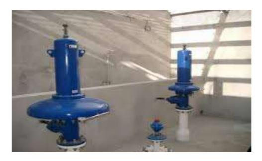
Figure (VI-5) : soupape de décharge
