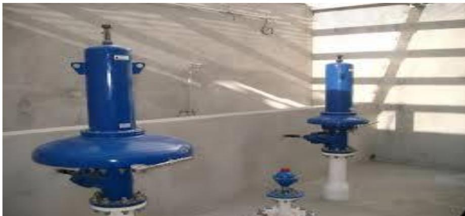
Figure (VI-3) : soupape de décharge
