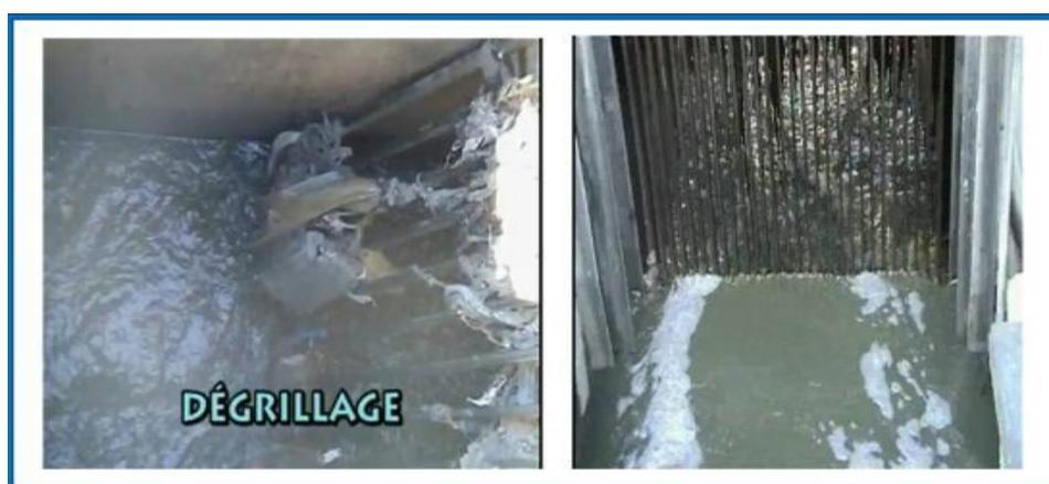
Figure III.1 : étape du dégrillage [15]
