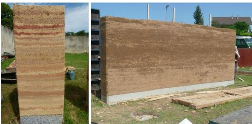
Figure III.9 - Mur construit avec la technique du pisé.
