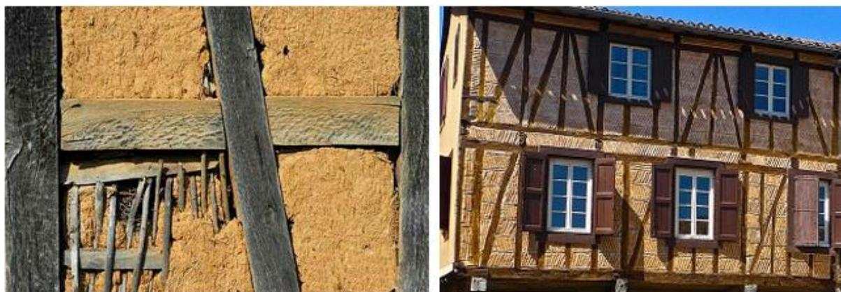
Figure III.6 - Image qui illustre une maison construite avec la technique du torchis.
