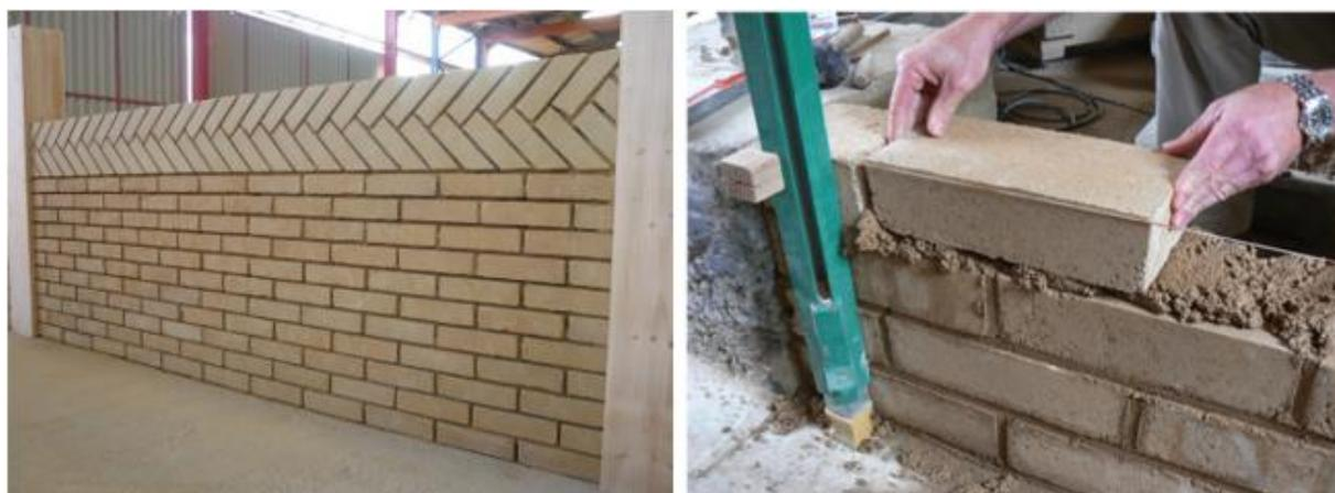
Figure III.12- Image qui représente les étapes de construction d'un mur en briques comprimées.
