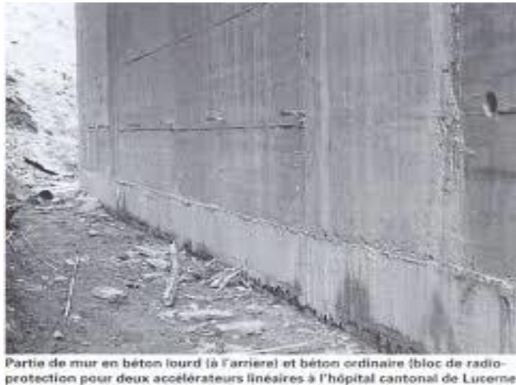
**Figure II.5 :** Partie de mur en béton lourd (à l'arrière) et béton ordinaire (bloc de Radioprotection pour deux accélérateurs linéaires à l'hôpital cantonal de Lucerne) [42].
