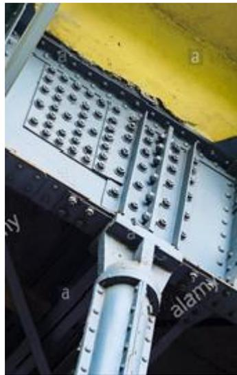
Figure 1-27: Assemblages boulonnés dans un pont en Belarus
