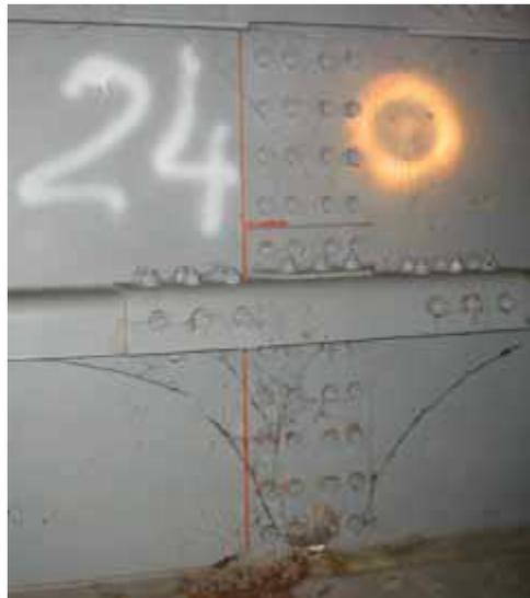
*Figure 3-29: Glissement des pièces au niveau d'un joint de rabouillage sous effort excessif (effondrement partiel de l'ouvrage). Mise en évidence par rupture du feuil de peinture et mise à nu de la sous couche au minium de plomb*
