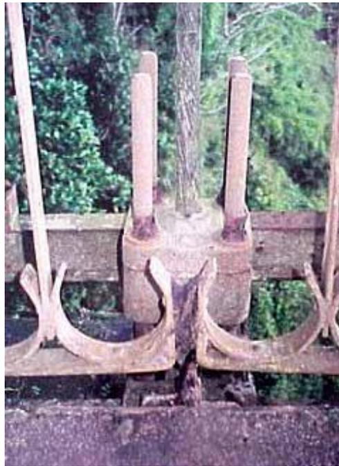
*Figure 3-27 : Corrosion spécifique des écrous d'une attache basse de suspente de pont suspendu*
