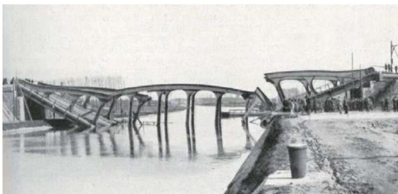
*Figure 2-4: Effondrement soudain d'un pont en raison de rupture fragile (Belgique 1938)*
