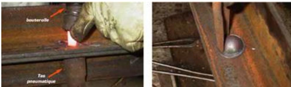
Figure 3-35: Pose d'un rivet à tête ronde et gougeage de la tête de rivet
