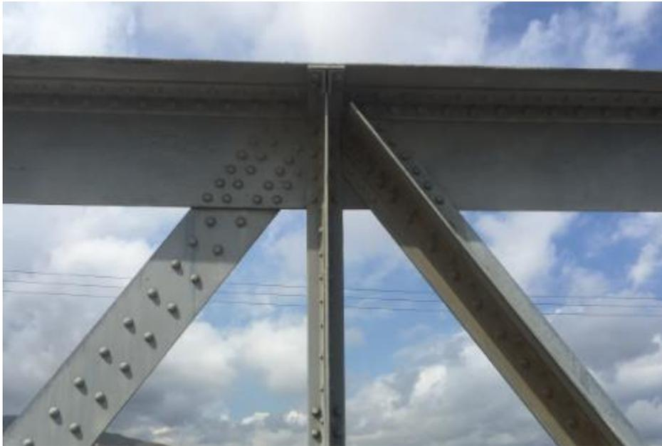
*Figure 4-8: image réelle de l'assemblages diagonale - montant - membrure supérieur*
