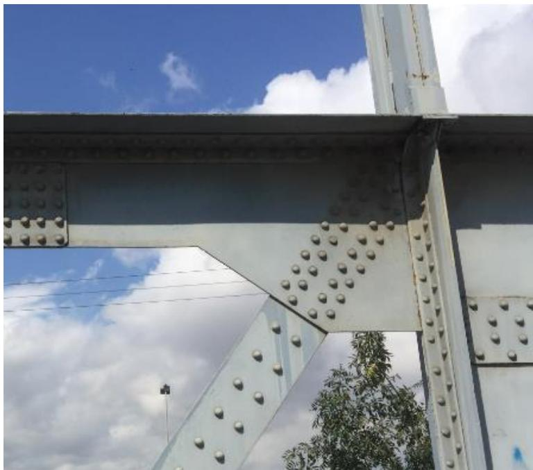
*Figure 4-9: image réelle d'un assemblage diagonale et membrure supérieur*
