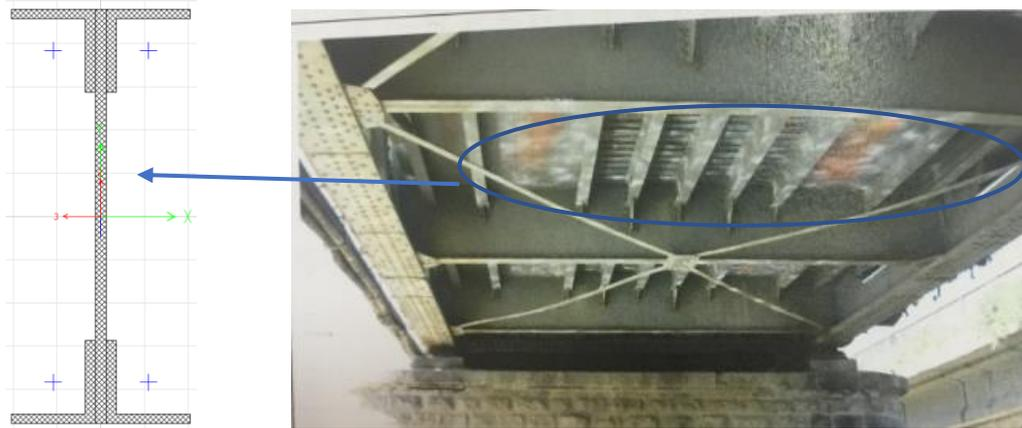
Figure 4-5: coupe transversale (à gauche) et vue réelle de la solive (à droite).
