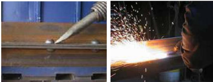
*Figure 3-32 Figure 3-33: Coupe d'une tête de rivet*
