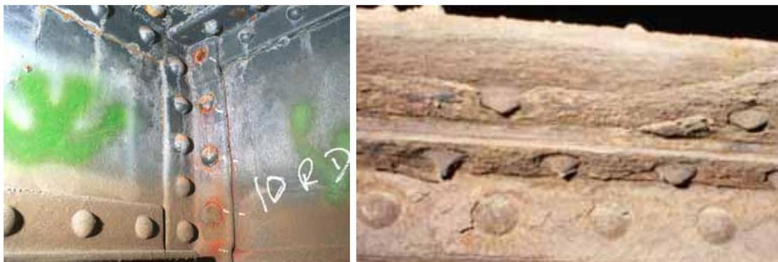
Figure 3-12: Déconsolidation d'assemblage rivé avec rupture de rivet
