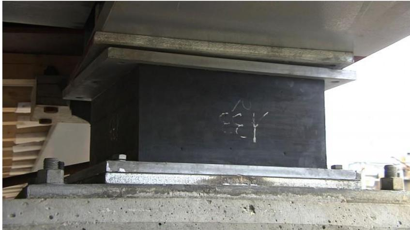
*Figure 4-7: appareils d'appuis d'un pont en élastomère fretté*
