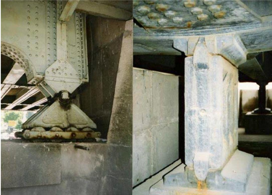
*Figure 3-18: Modification souhaitable    Figure 3-19: corrosion à traiter lors de la remise En peinture de l'ouvrage*
