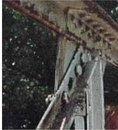
*Figure 3-28: Déconsolidation d'un assemblage boulonné non précontraint d'une diagonale d'une poutre treillis avec disparition d'un boulon de l'assemblage.*
