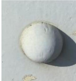
Figure 4-18: Rivet utilisé dans l'assemblage des éléments du pont de Soummam
