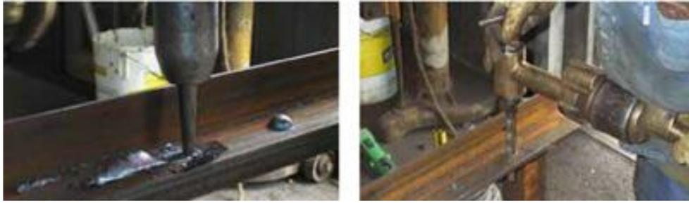
Figure 3-34: Chasse du corps du rivet et alésage du trou au diamètre supérieur
