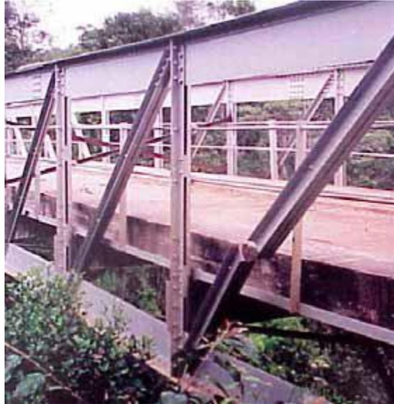
*Figure 3-1: Rupture d'une diagonale tendue sur un point de soudure*
