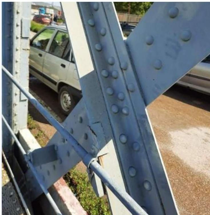
*Figure 4-11: image réelle d'un assemblage garde de corps montant*
