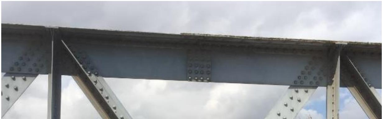
4: Image réelle de l'assemblage diagonales-montant-membrure supérieur
