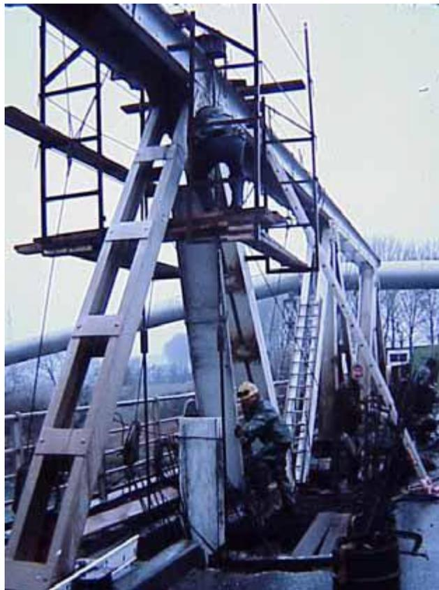
Figure 3-8: Remplacement d'un montant d'une poutre treillis – dispositif provisoire de reprise des efforts par barres de brelage
