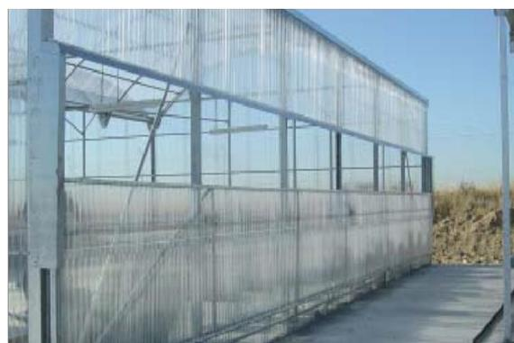
Figure I.4 : Ouverture par déplacement vertical [15].
