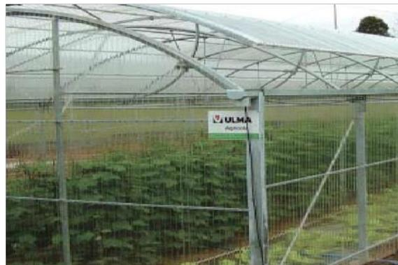
Figure I.3 : Une aération uniforme située sur le faîtage [15].
