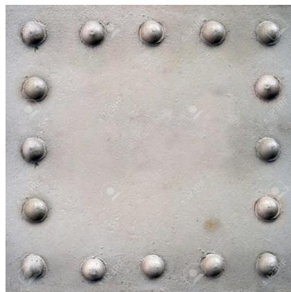
Figure IV. 2 Ligne de rivets à tête ronde sur fuselage d'avion
