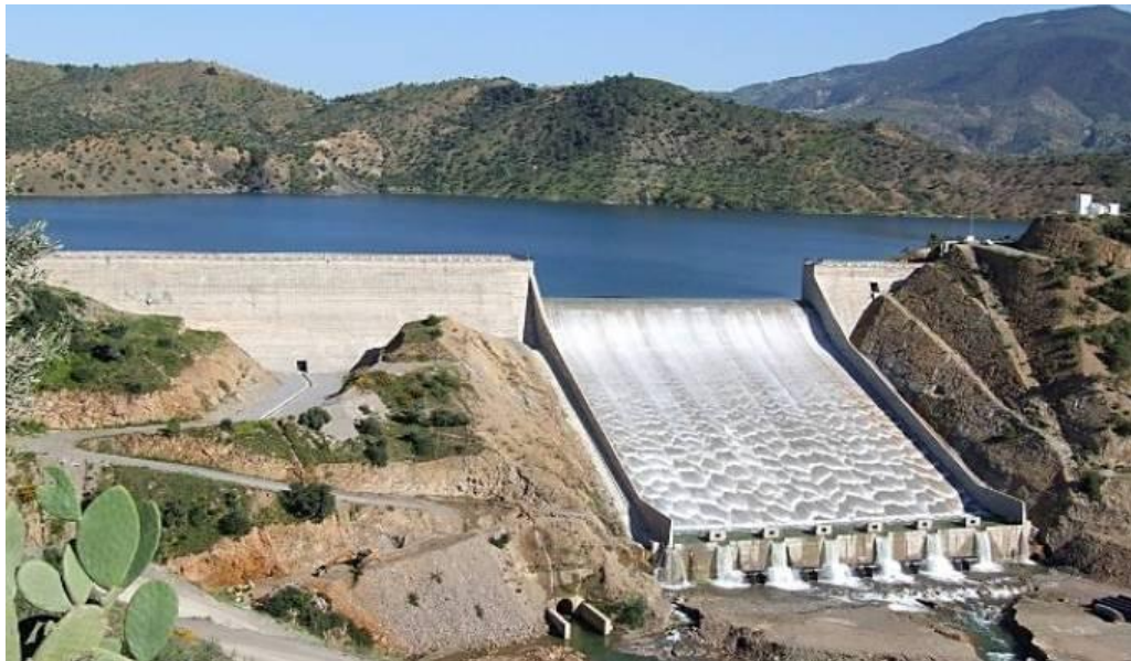
Figure 05 : Vue globale du barrage de Tichy Haf (Collection personnelle, 2019).
