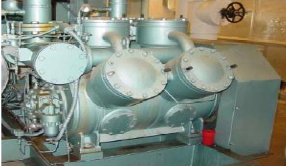
**Figure I.5:** Compresseur à pistons.
