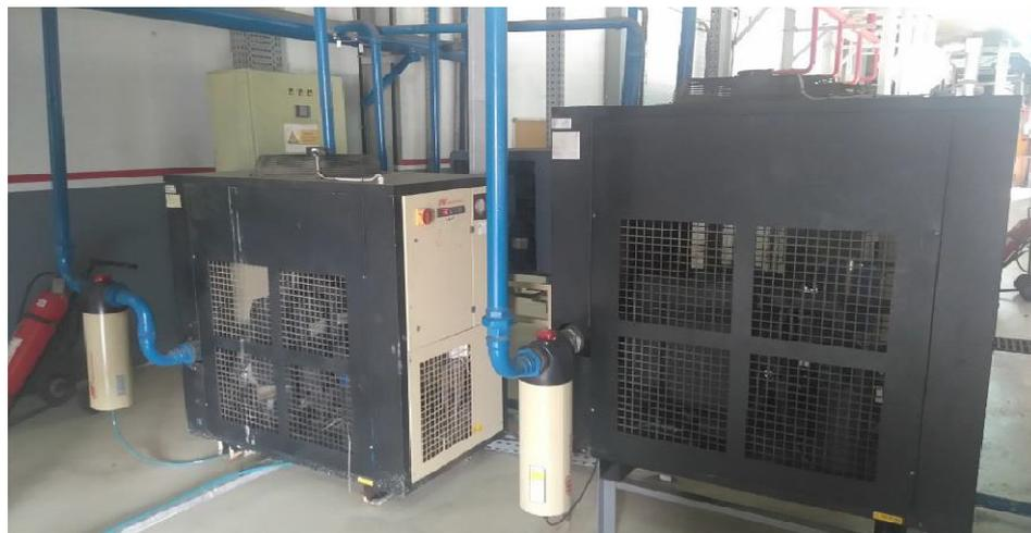
**Figure II.15:** Sécheur d'air comprimé.
