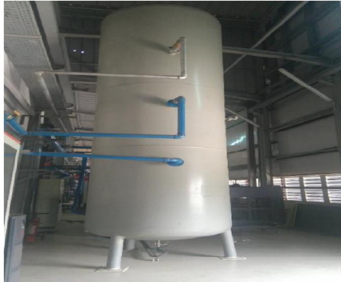
**Figure II.14:** Réservoir d'air comprimé.
