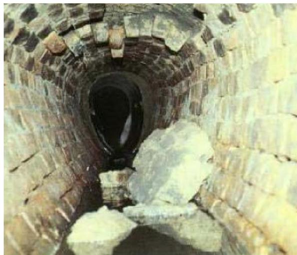
Fig II.5. Dégradation de parement. (BOUKHOBZA, 2016)
