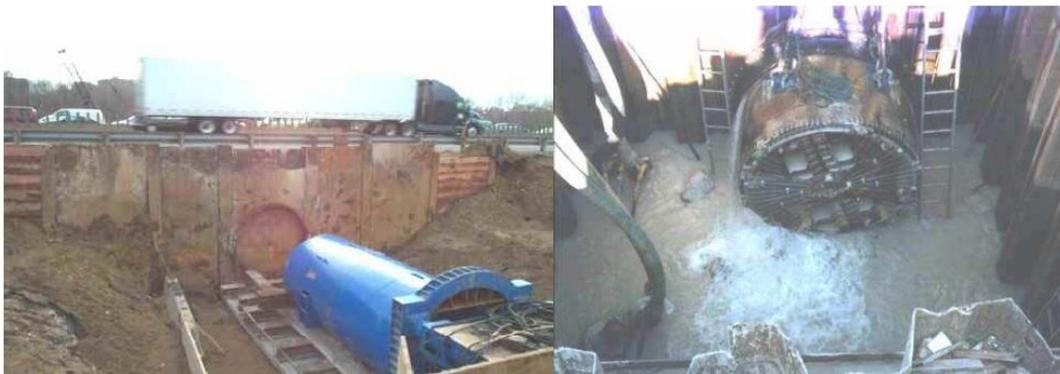
*Fig II.11. La technique de micro-tunnelier.* (BENOIT et DESBIENS, 2012)
