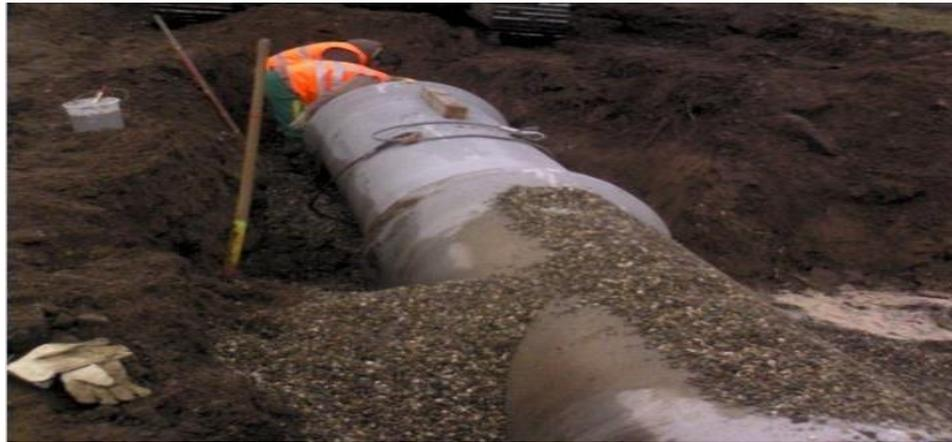
*Fig I.7. Conduites en béton armé.* (BECK, 2008)
