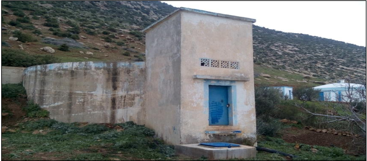
Figure (I.6) : Réservoir du Tacheta 500 m 3
