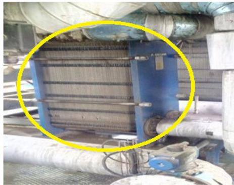
**Figure I.10 :** Un échangeur à plaques.
