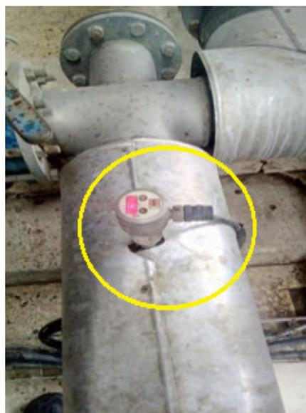
**Figure I.19 :** Capteur de pression.
