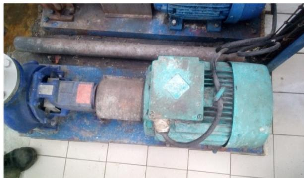
**Figure I.7** : Pompe centrifuge.
