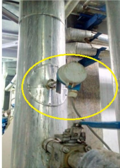
**Figure I.18:** Une sonde de température.
