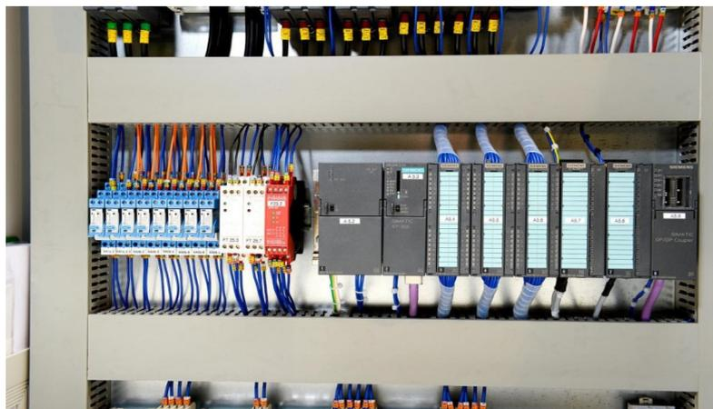
Figure III.6: Automate programmable, type modulaire (SIEMENS).
