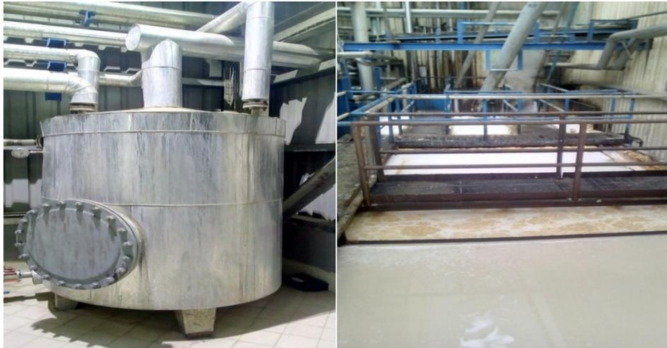
**Figure I.14** : Une cuve et un bac en acier.
