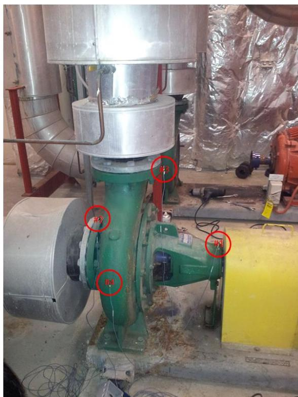
Figure (IV.10). Points de mesure des signaux vibratoires sur la pompe [23].
