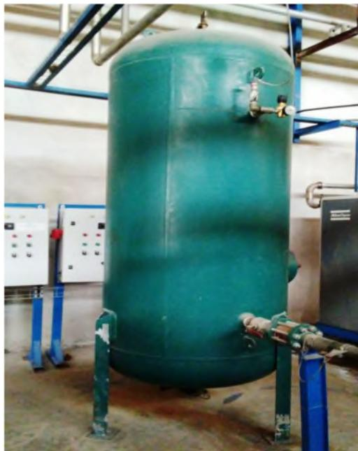
Figure II. 14 : Réservoir d'air.
