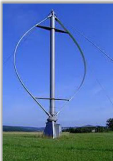
*Figure I.8 : Eolienne à axe vertical la Darrieus [11].*
