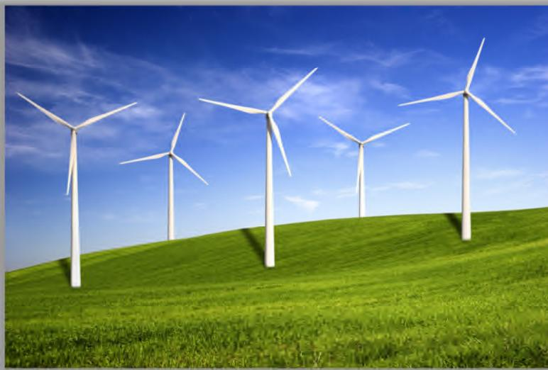
*Figure I.9 : Eolienne à axe horizontal*
