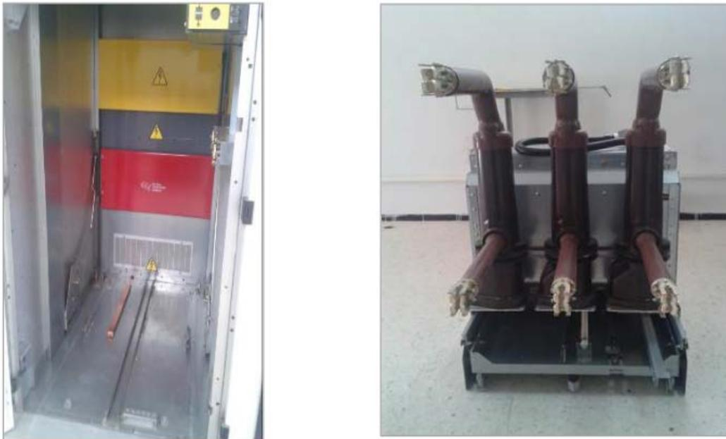
**Figure II. 9:** Compartiment disjoncteur [8].
