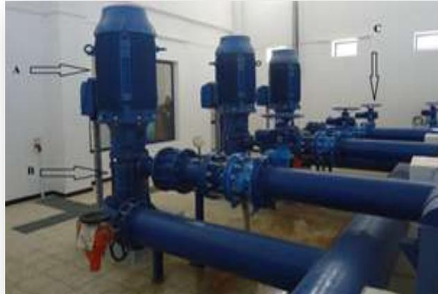
*Figure(I.11) : Actionneurs de la station (A: moteur ; B: pompe ; C : vanne).*
