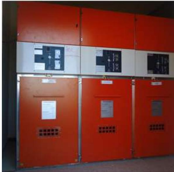
*Figure (II.5) : Cellule de protection générale CLPG.*
