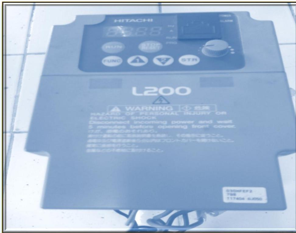
Figure III-6 : Variateur de fréquence
