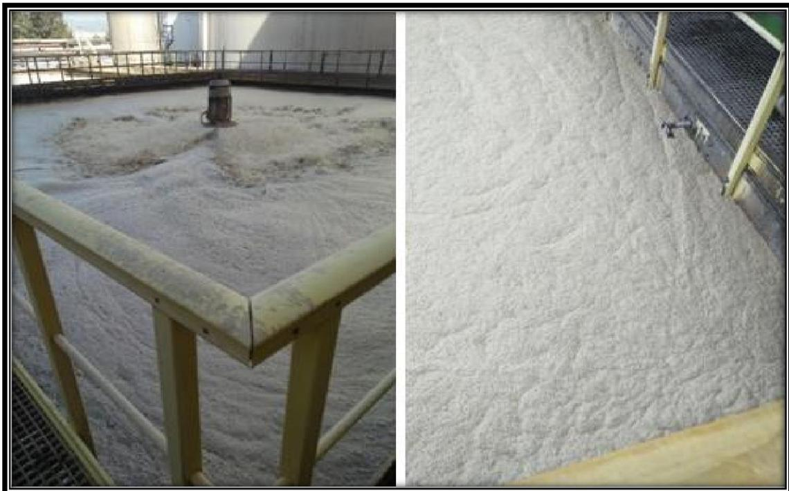
**Figure 25-** Bassin d'aération : à droite, en état stable ; à gauche, en état d'agitation.
