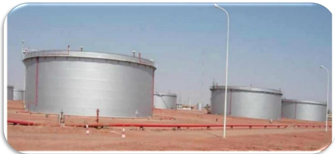
**Figure I.9. :** Les réservoirs à toit flottant.
