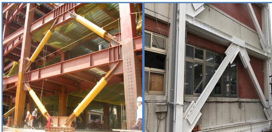
**Figure 9 :** Contreventement en V dans des bâtiments en charpente métallique.
