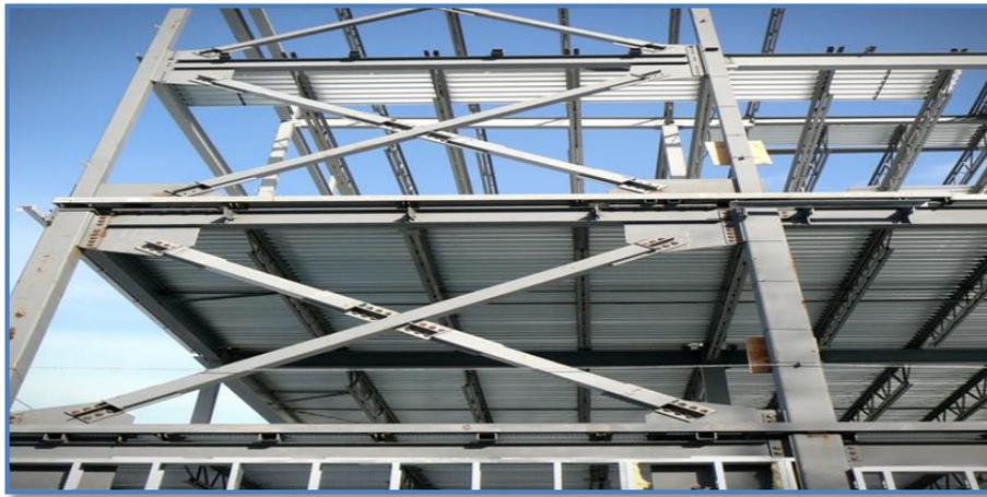
**Figure 7 :** Contreventement en X dans un bâtiment en charpente métallique.
