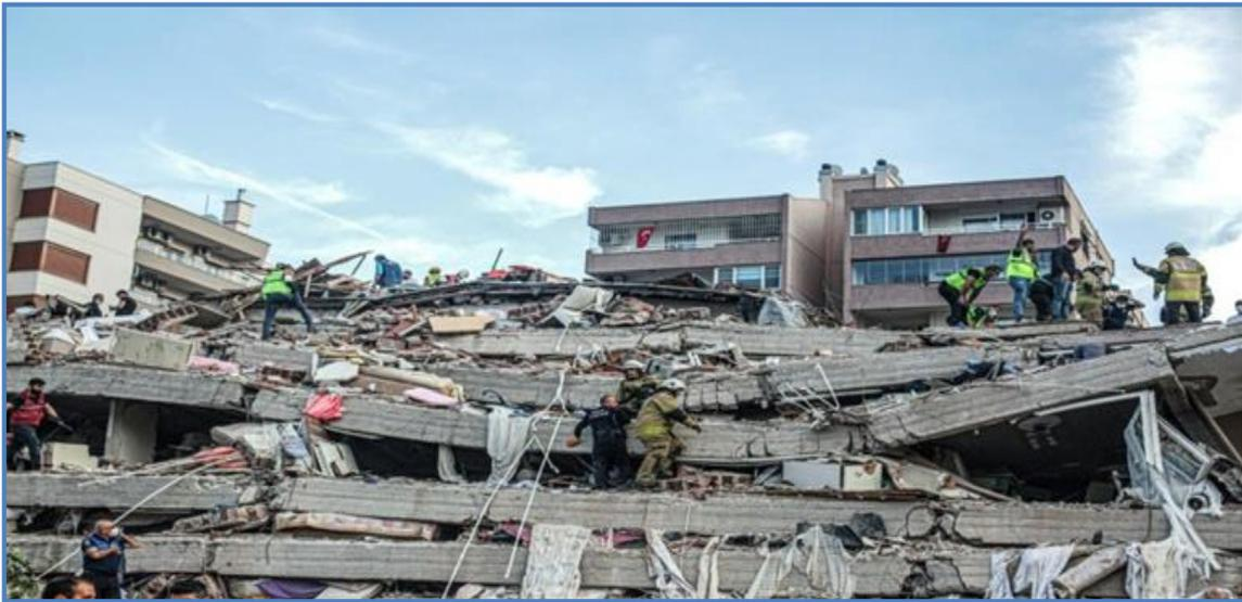
**Figure 5** : Effondrement total des constructions non ou mal contreventées.
