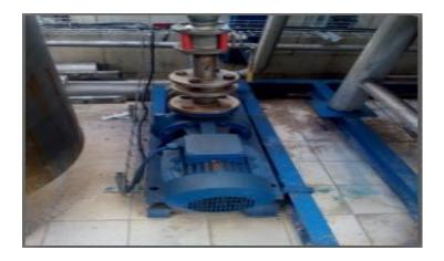
Figure II.15: Pompe centrifuge
