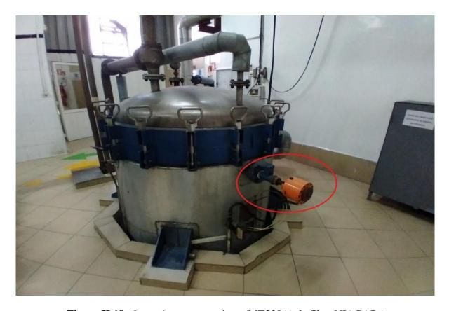
Figure II.18: le système pneumatique (MT330A) de filtre NIAGARA.
