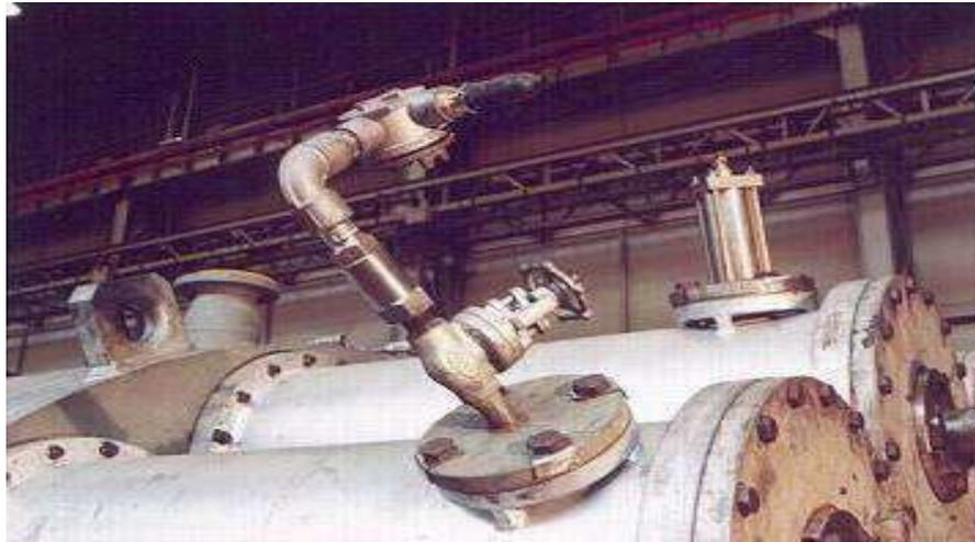
Figure (II.8) : Détecteur de flamme ultraviolette.
