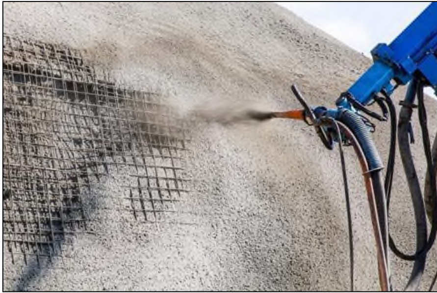
Figure II.5 Béton projeté renforcé par du treillis soudé. [18]
