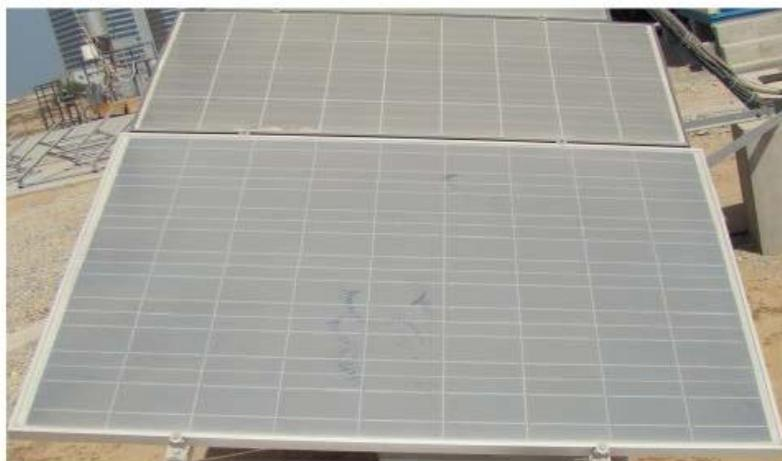
**Figure II.9 :** Accumulation de particule de sable sur un module.
