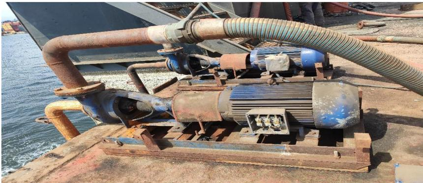
**Figure II.2 :** Pompe centrifuge.
