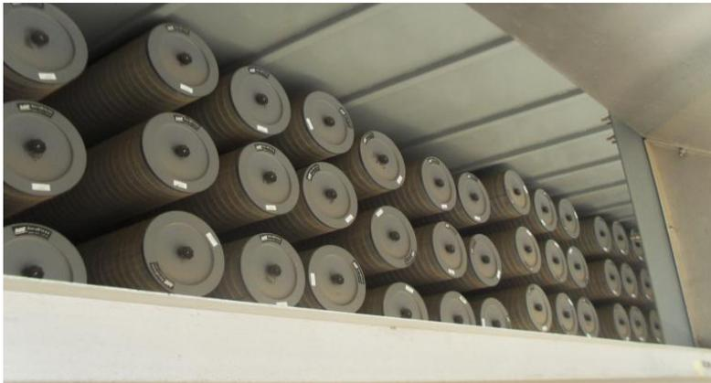
Figure I. 9: Filtres d'air[2]
