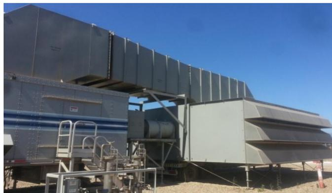
Figure I. 8: Système d'aspiration et de filtration d'air[2]
