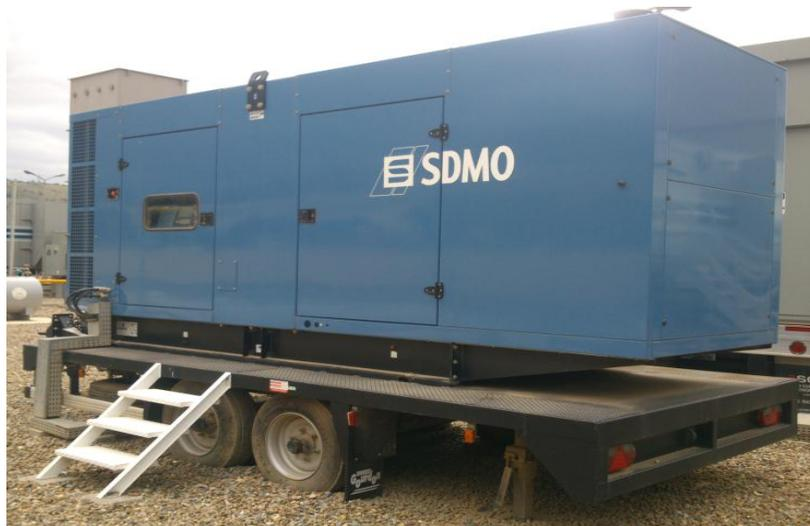
Figure I. 11: Groupe Diesel de secours[2]
