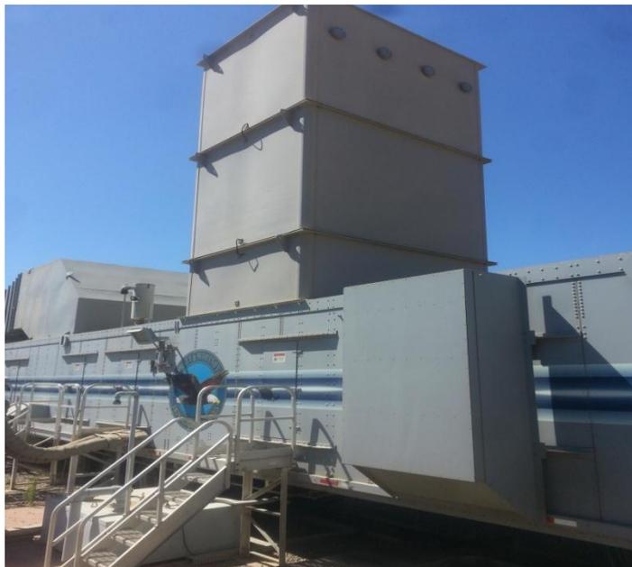
Figure I. 10: Système d'échappement avec silencieux[2]
