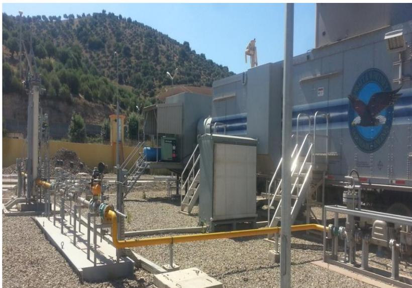
Figure I. 6: Système d'alimentation en gaz naturel[2]
