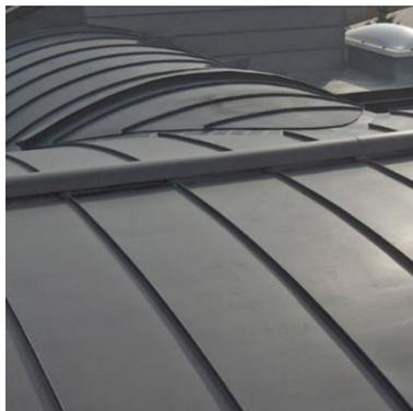
**Figure I-15:**Couverture en zinc à joint-debout.
