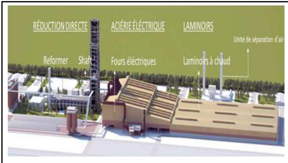
**Figure I.2 :** Disposition des unités de production de l'AQS dans sa phase 1.
