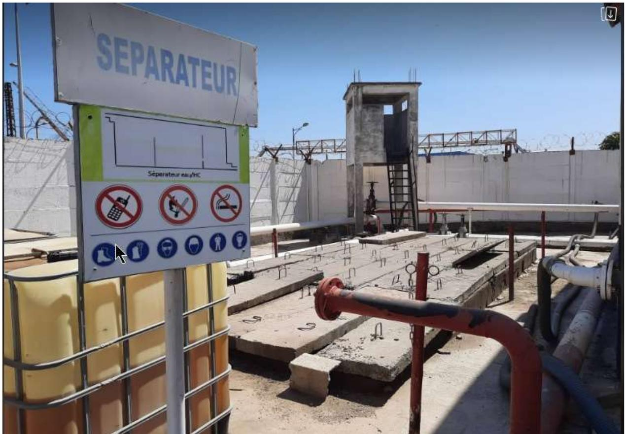
**Figure II.3** : Vue sur terrain du séparateur sous terrain R1 E/HC de classe II du district carburant NAFTAL – Béjaïa.
