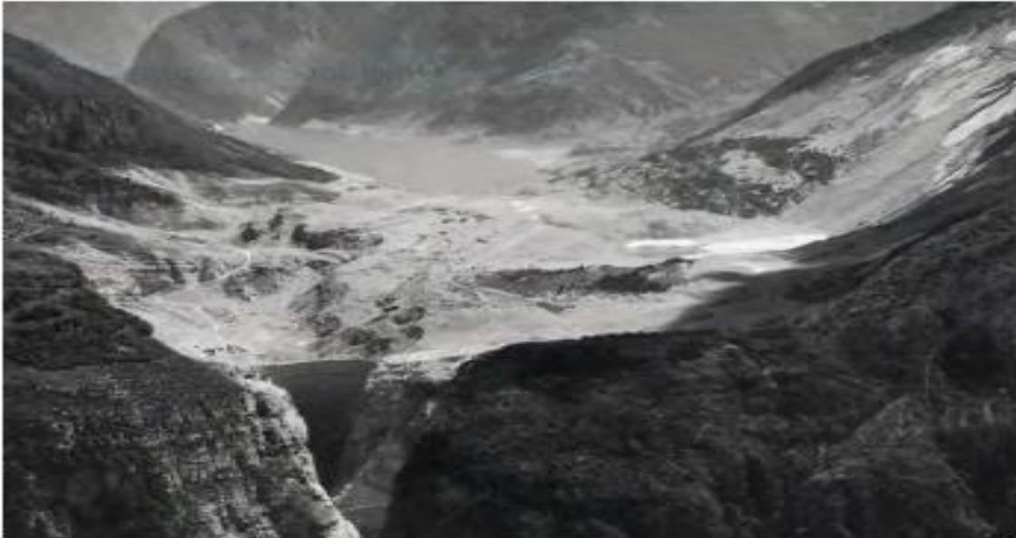
*Figure I.4 : barrage du Vajont après le mouvement de terrain du 9 octobre 1963.*
