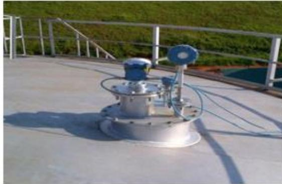
**Figure 5:** Télé-jaugeur du radar de niveau de bac de pétrole [5]
