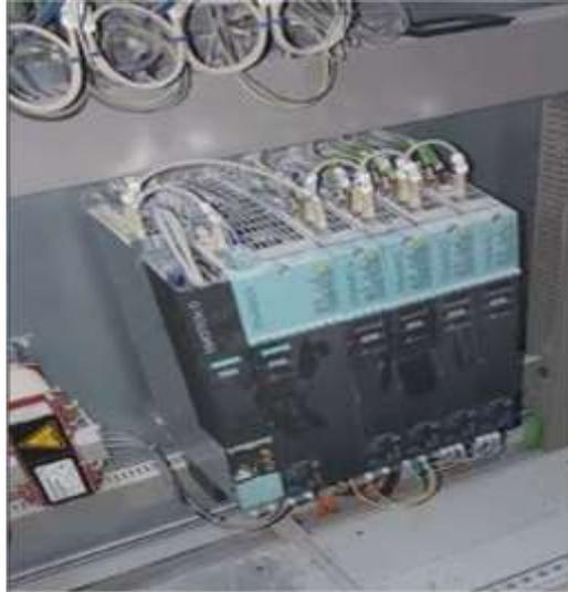
Fig.3 Automate SIMOTION D sur terrain de travail
