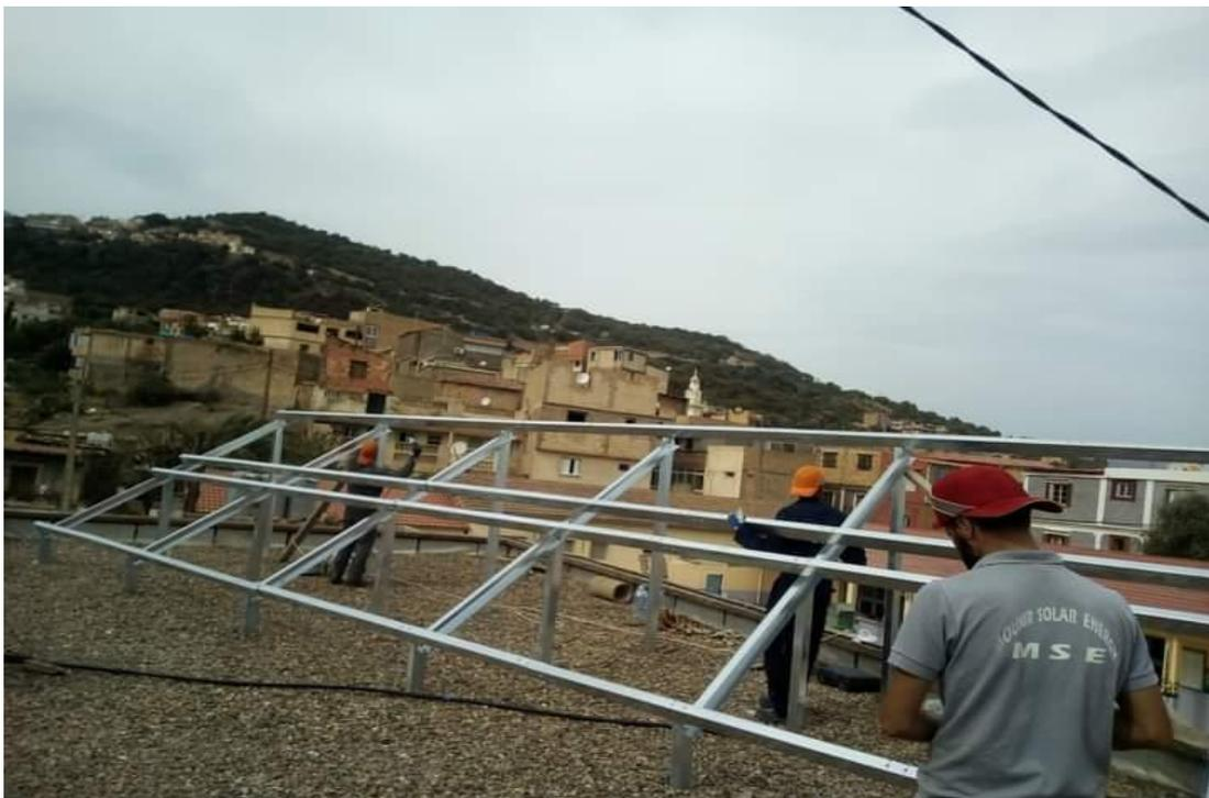
**Figure III. 5:** Réalisation de la structure
