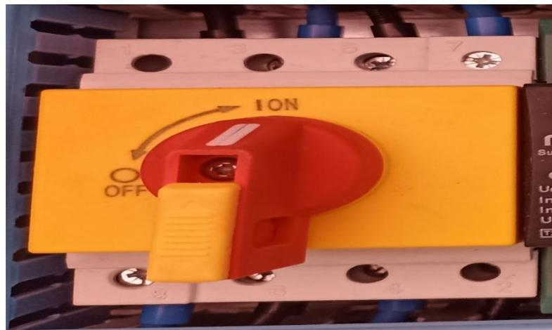
**Figure III. 16:** Sectionneur
