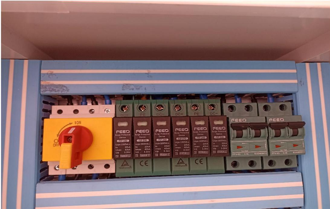
**Figure III. 15:** Eléments de protections partie DC
