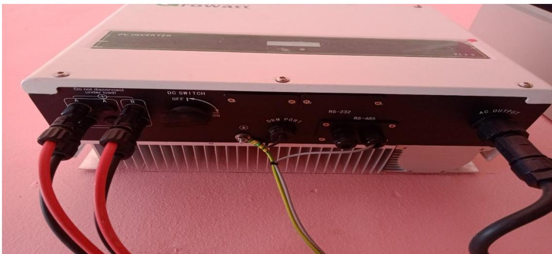
Figure III. 12: Branchement de l'onduleur
