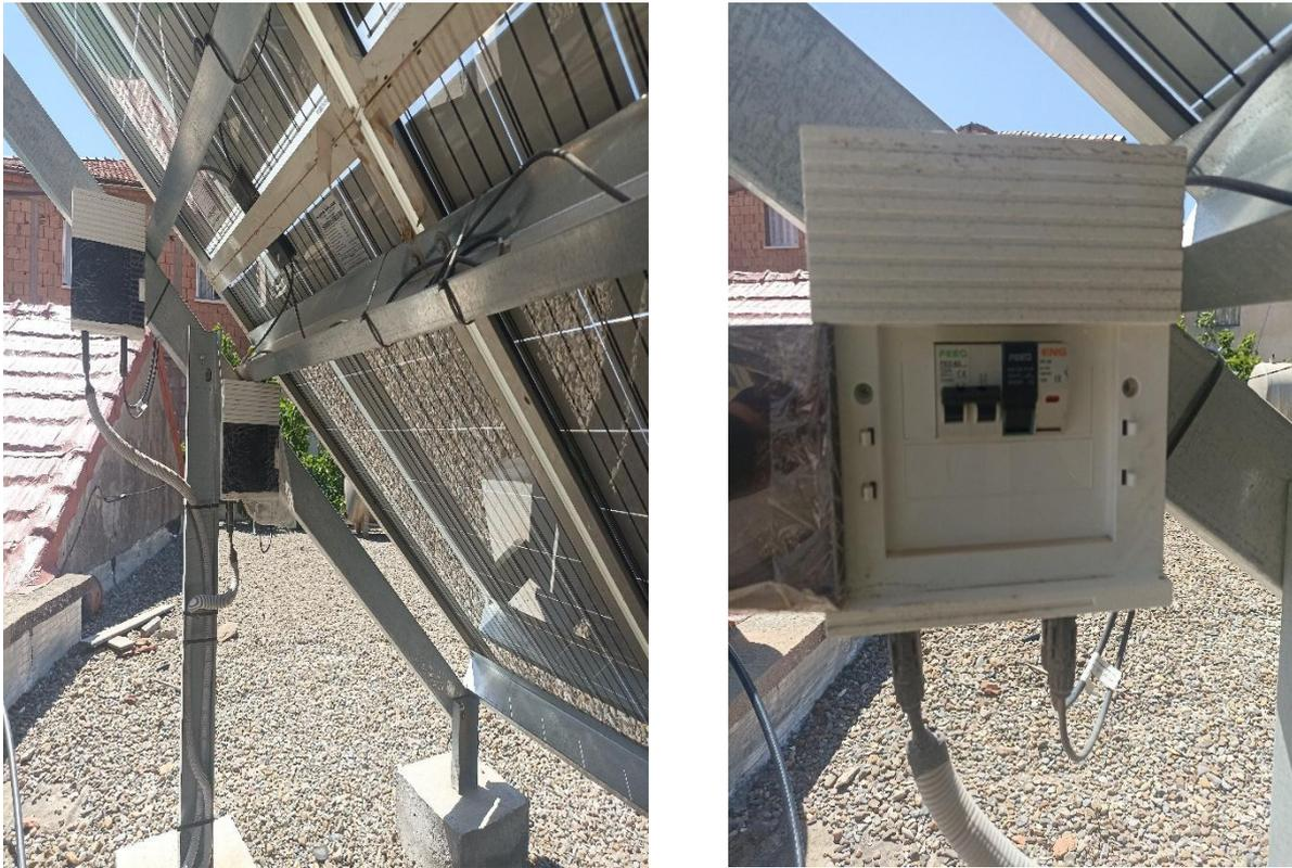
**Figure III. 8:** Les boîtes de jonction
