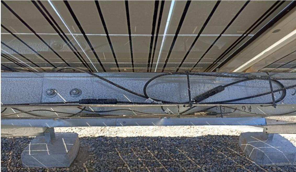
**Figure III. 6:** Raccordement des panneaux en série
