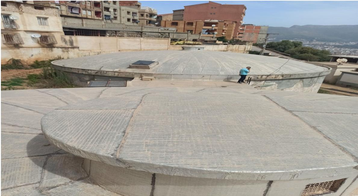
Figure III-6. Etanchéités de toit, pour les deux réservoirs et la chambre de vannes
