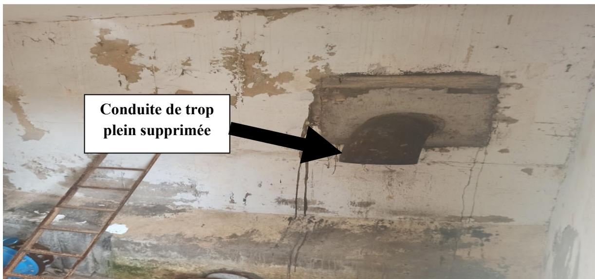
Figure III-3. Conduite de trop plein supprimé
