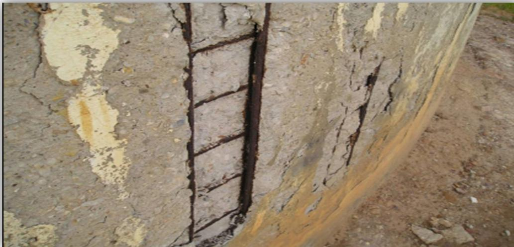
**Figure III-12.** Visibilité des armatures sur le mur du réservoir
