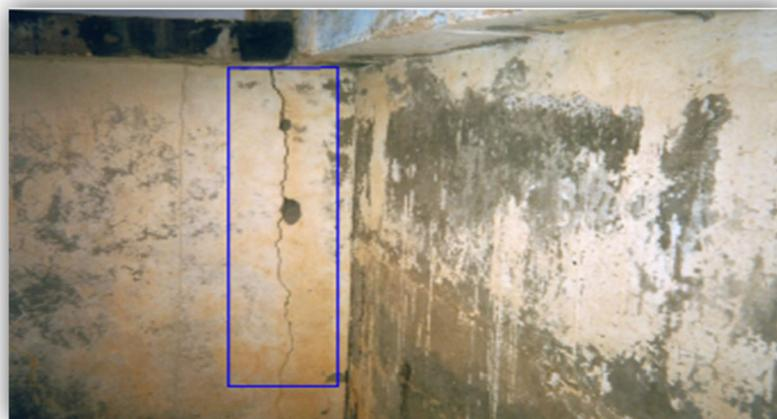
Figure III-16. Fissures sur la chambre des vannes
