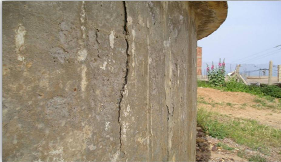
Figure III-15. Dégradation généralisée du béton
