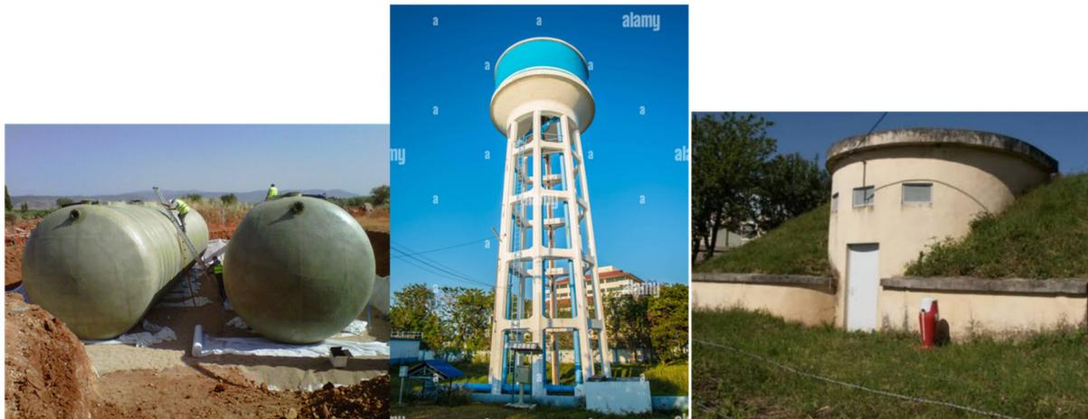
**Figure IV-2.** Classification des réservoirs selon leurs emplacements
