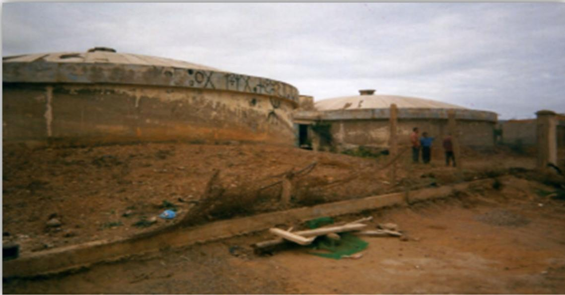
Figure III-11. Les deux réservoirs A et B, entre eux la chambre des vannes
