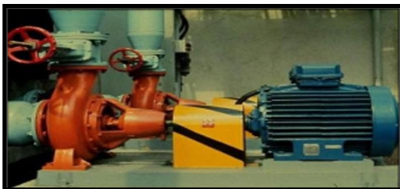
Figure VI-2. Pompe centrifuge à axe horizontale avec vannes d'isolement.
