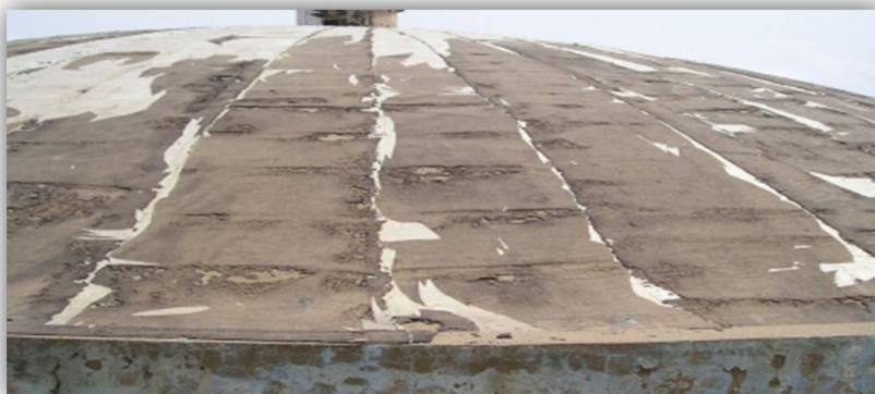
Figure III-13. Étanchéité dégradée.
