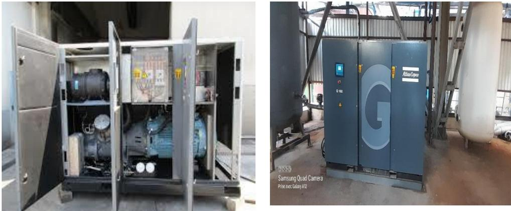
**Fig. III. 3 :** Photo réelle d'un compresseur à vis.
