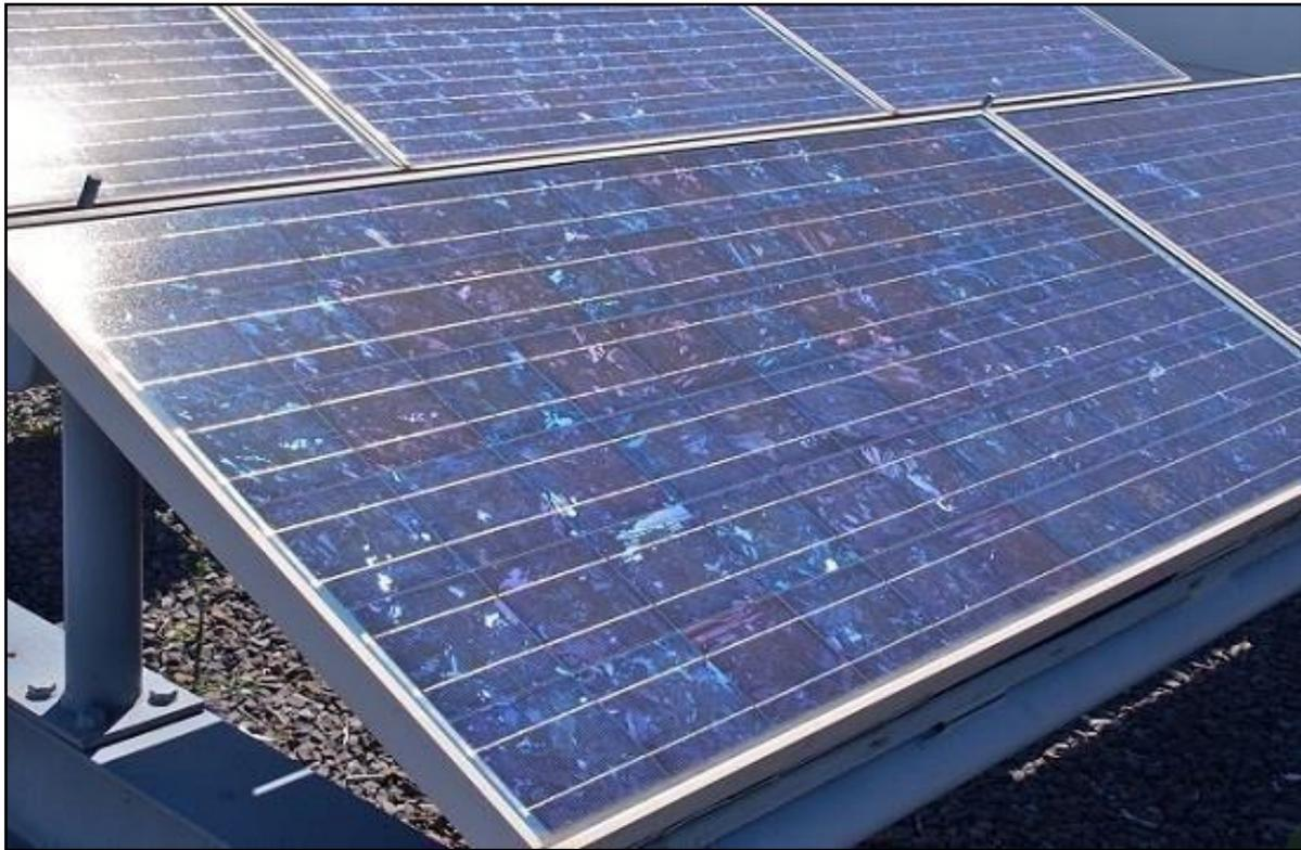
**Figure 3.8 :** Panneaux photovoltaïques polycristallin
