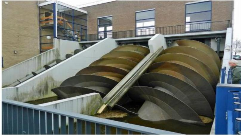
**Fig. III. 5 :** Machine élévatoires simple à vis d'Archimède
