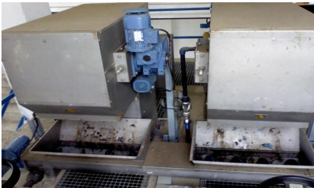
**Figure II.6:** Dégrilleurs de la STEP de SAL
