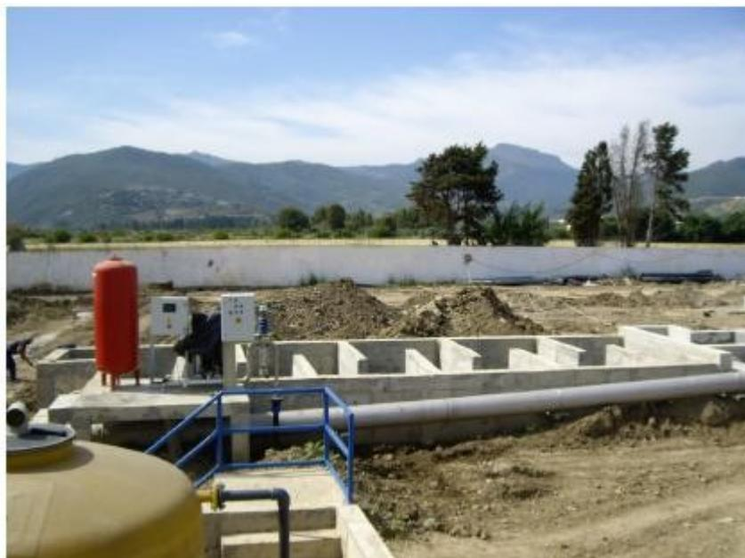
Figure II.16 : bassin da chloration
