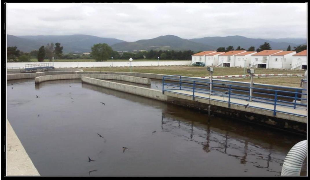
**Figure II.8:** Réacteur biologique (système Carrousel) de la STEP SAL
