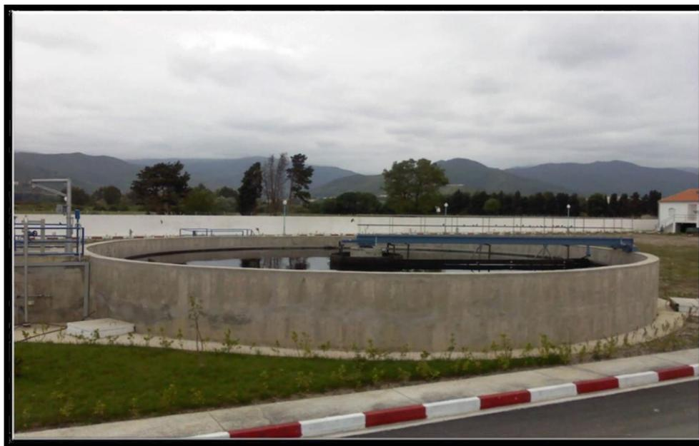
**Figure II.11:** clarificateur de la STEP SAL
