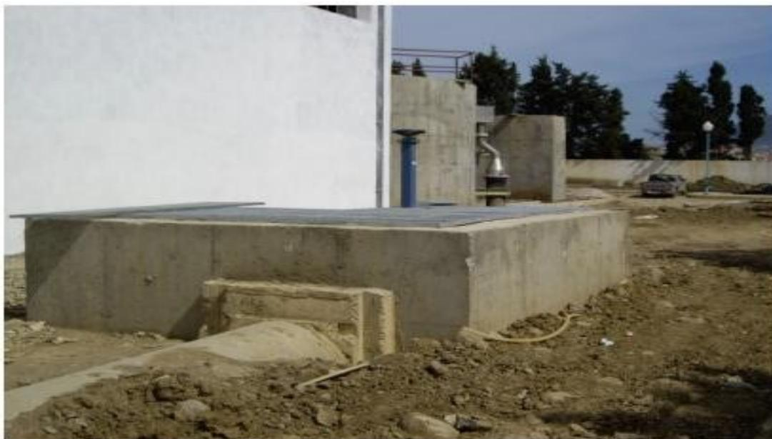
**Figures II.3:** canal d'arrivée d'eaux usées de la STEP SAL
