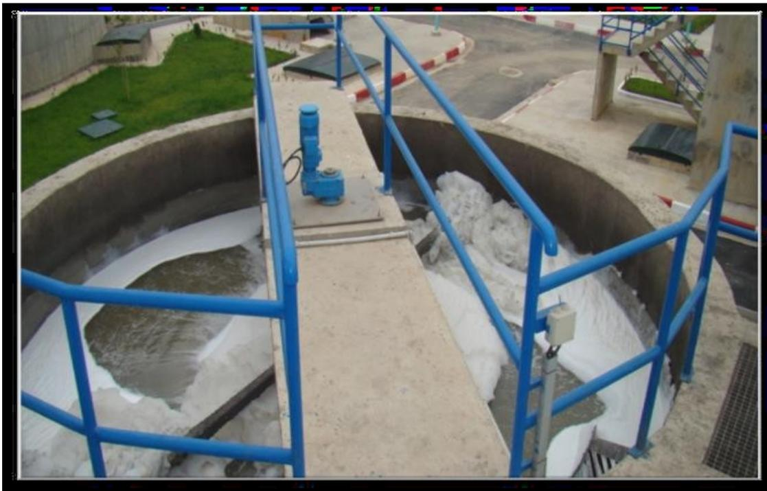
**Figure II.7 :** bassin de dessablage et déshuilage de la STEP SAL
