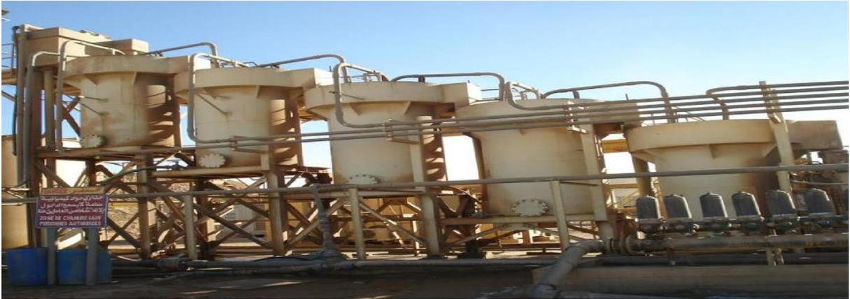
Figure II.10. Les colonnes de charbon [photo prise 2022]
