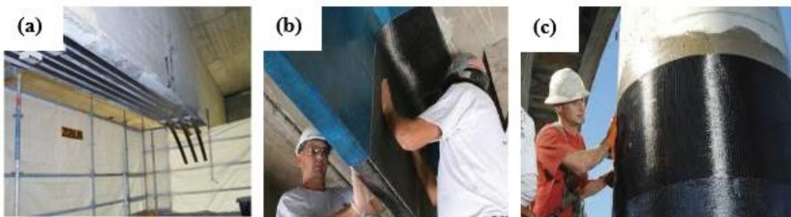
**Figure I.12.** Cas d'application de renforcement extérieur des structures (SikaWrap®).
