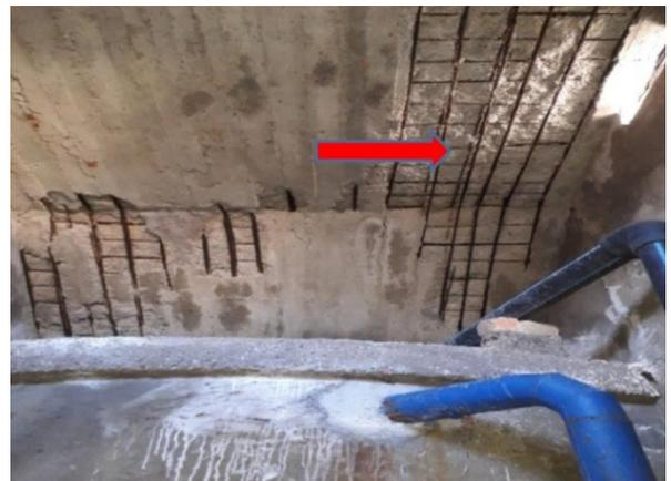
**Figure 23:** Ferrailages de la coupole
