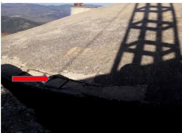
**Figure 24:** Etanchéité du réservoir
