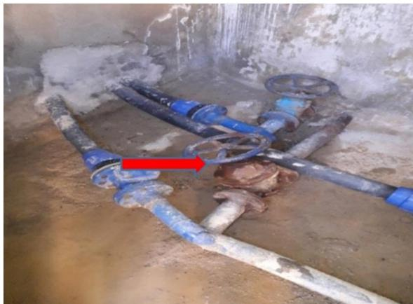
**Figure 22:** Vannes corrodées
