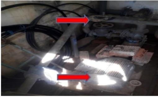
Figure 8: Vanne corrodé et pompe défailante
