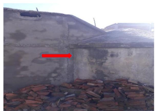
**Figure 25:** Fissuration des parois
