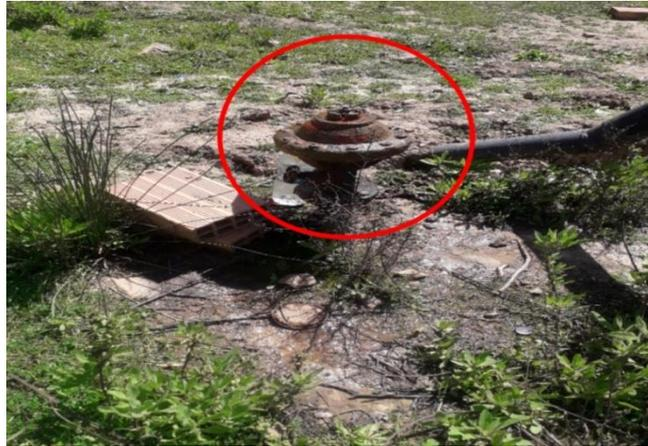
**Figure 27:** Etats de la soupape et de la conduite d'adduction
