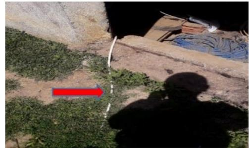
Figure 10: Câbles électriques apparents
