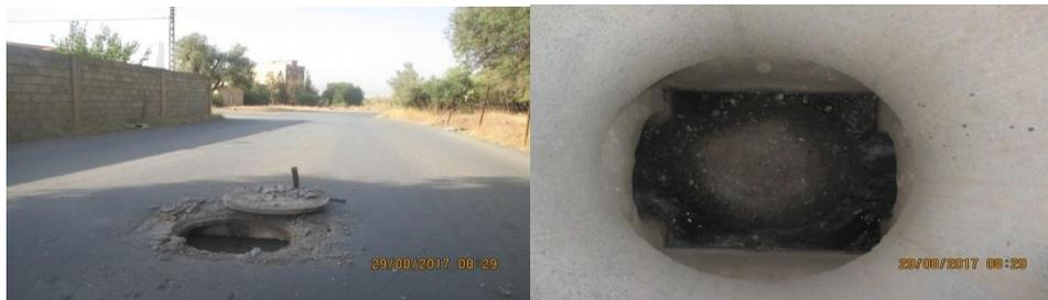
**Figure III.4 :** Regard avec partie circulaire et partie rectangulaire
