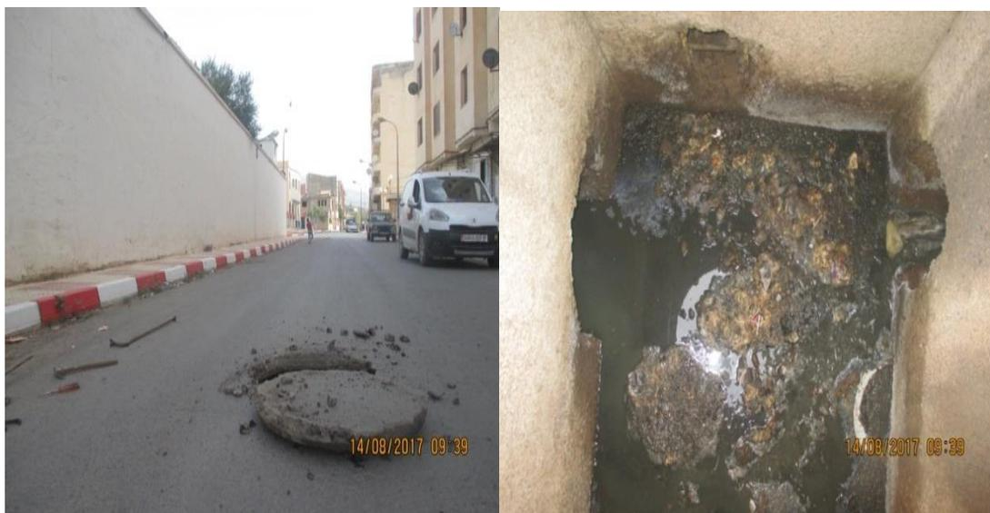
**Figure III.25:** Collecteurs en buse de béton avec des regards en tampon en fonte
