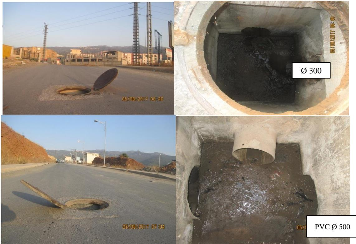
**Figure III.29:** collecteurs des eaux pluviales en PVC
