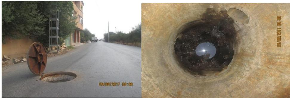
**Figure III.3 :** Regard circulaire avec tampon en fonte
