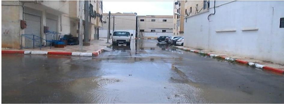
**Figure III.26 :** Refoulement d'eau au niveau d'un avaloir
