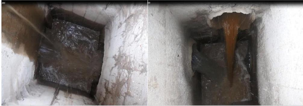
**Figure III.9 :** Réseau EU +EP /temps de pluie
