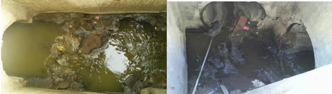
**Figure III.22:** Regards en buse de béton
