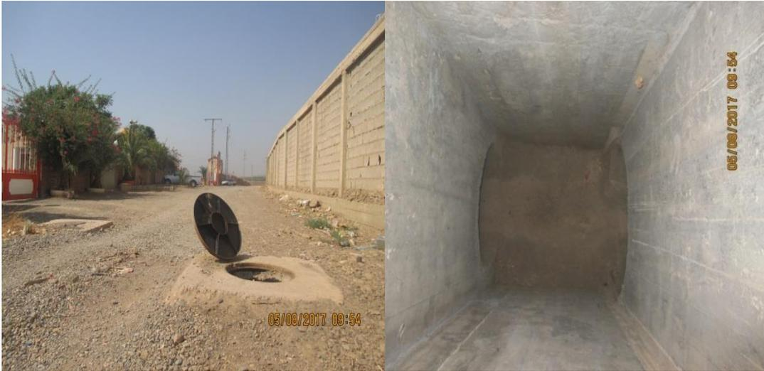
**Figure III.31:** Collecteurs en PVC avec des regards en béton armé
