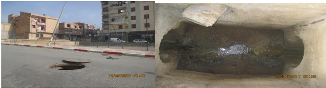
**Figure III.24 :** Regards en béton avec tampon en fonte
