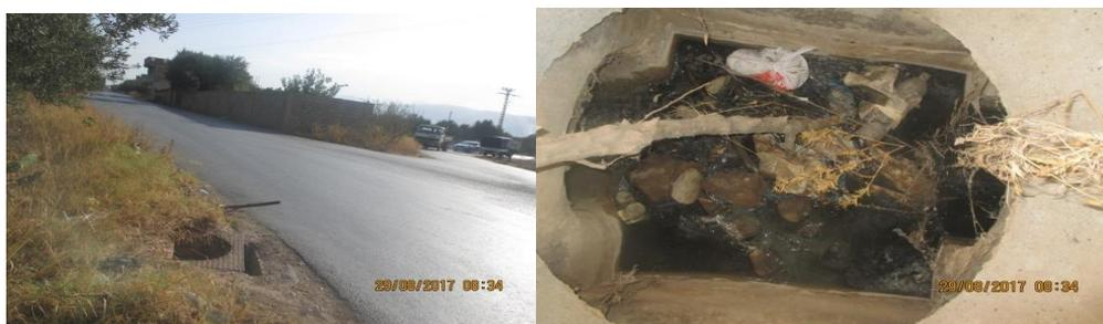
**Figure III.5 :** Regard avec tampon endommagé
