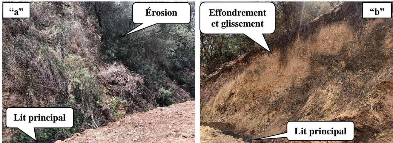
Figure (V.2) : Érosion et glissement des berges (Photo prises le 01/05/2023).
