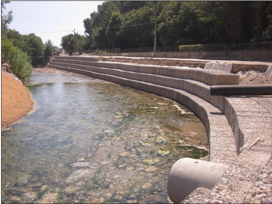
*Figure (VI.1) : Mur de soutènement en gabionnage (Image tirée du web).*
