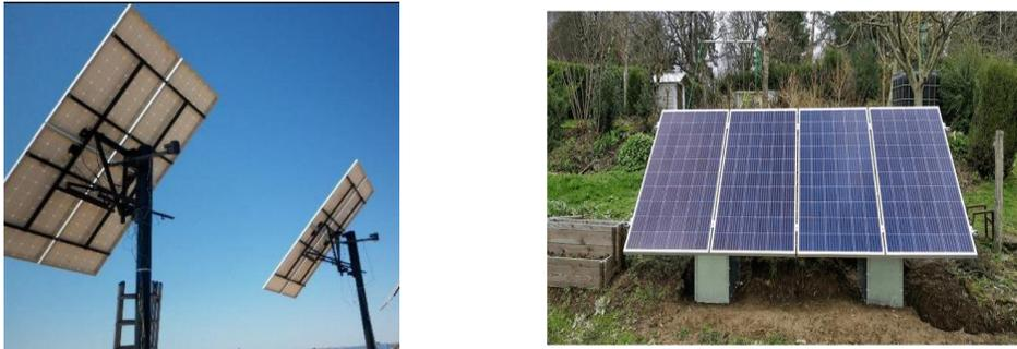
Figure I.4: Installation avec et sans suiveur solaire
