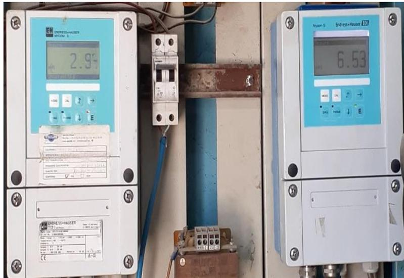
**Figure III.1** : Appareil ph mètre, représentant la face de devant (photo prise en entreprise).
