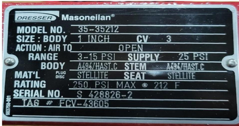
Figure III.14 : Référence de la vanne modulante pneumatique (photo prise en entreprise).
