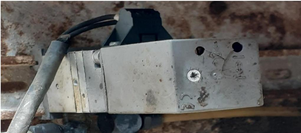
**Figure III.10** : Le convertisseur courant/pression (photo prise en entreprise).
