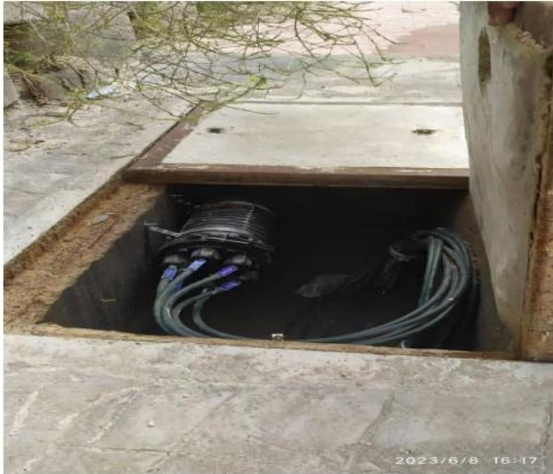
**Figure III.9** : Boitier de protection d'épissure (BPE)
