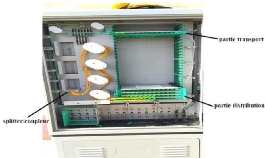
**Figure III.10 : Armoire SRO**
