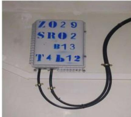
**Figure III.14** : PBO intérieur
