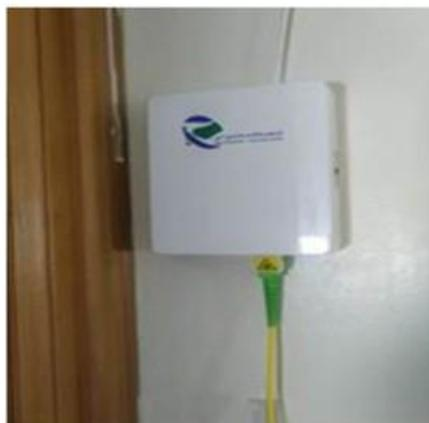
**Figure III.18** : Prise optique
