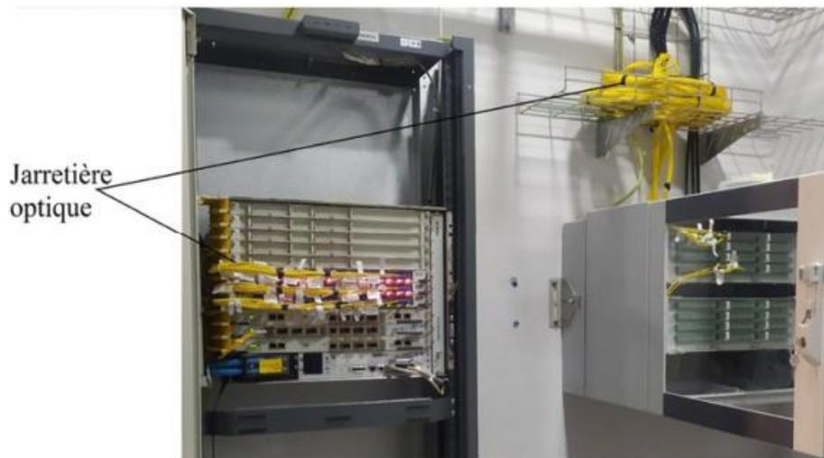
**Figure III.8** : Raccordement entre l'OLT et l'ODF
