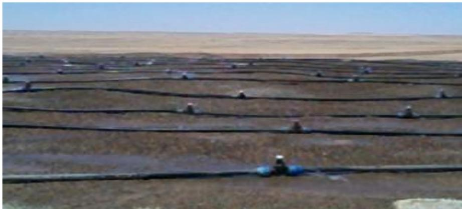
**Figure I-11** : Arrosage du tas en goutte à goutte.
